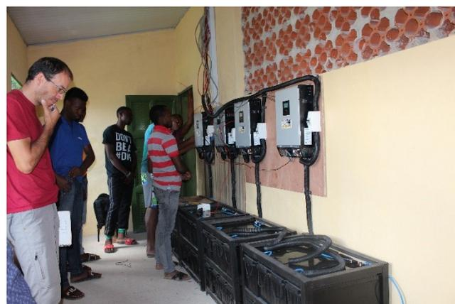
*Installation der 4 Wechselrichter (an der Wand) und die 32 Batterien (am Boden)*
